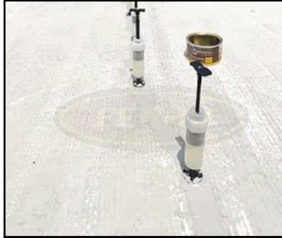
ฉีดซ่อมรอยร้าวด้วยชุดฉีดพ่น ฉีดซ่อมรอยแตกร้าวคอนกรีต (เฟอร์โรเรซ 717/คิท)
